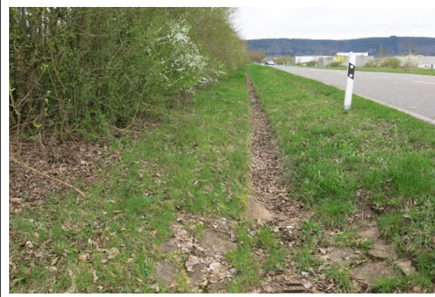
Foto 7: L 48 mit straßenseitigem Rain, Betonrinne und Gehölzstreifen
