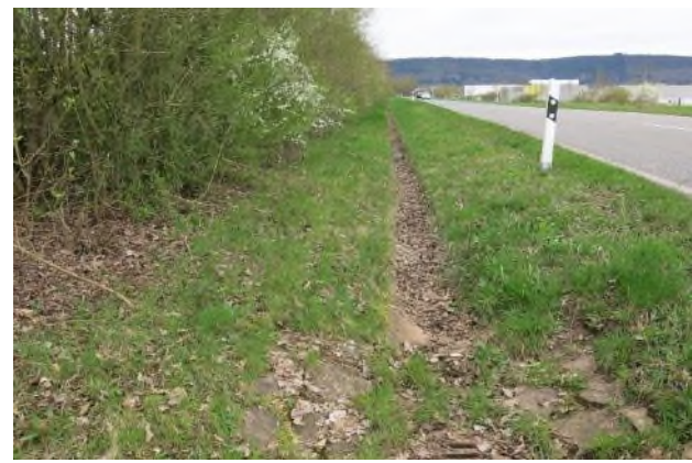
Foto 7: L 48 mit straßenseitigem Rain, Betonrinne und Gehölzstreifen
